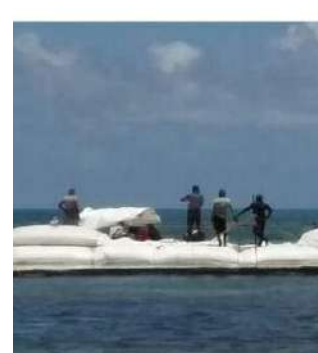
Arrecife de Concreto
